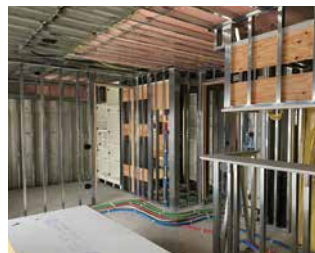
通電前の屋内作業に
